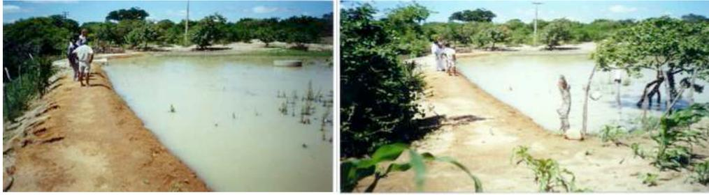
Figura 22: Barragem subterrânea da comunidade Riacho Verde com uma lâmina rasa de água, apropriada para o cultivo da cultura de arroz
