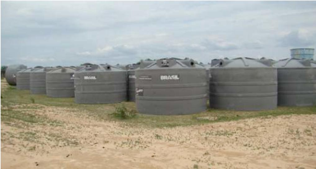
Figura 15: Cisterna de uso familiar para armazenamento da água da chuva e utilização no período de estiagem do *Programa Água para Todos*
