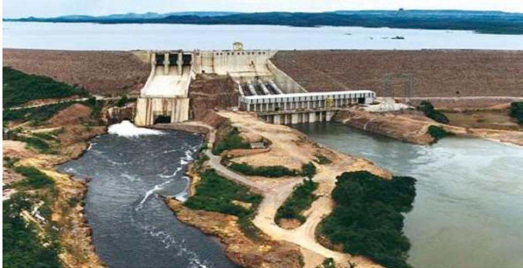
Figura 32: Usina de Manso (MT), a barragem de Manso tem a finalidade de regularizar os ciclos de cheias e secas do rio Cuiabá, como também de geração de energia elétrica
