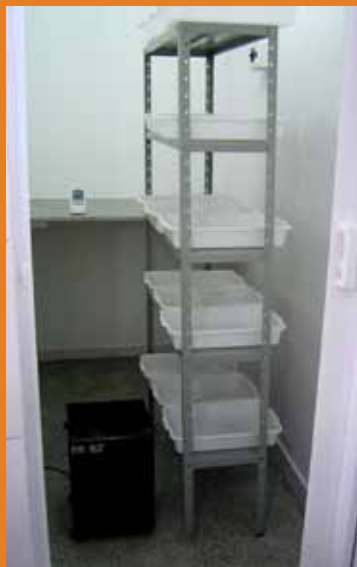
Sala de desumidificação, equipada com um desumidificador de ar e prateleiras
