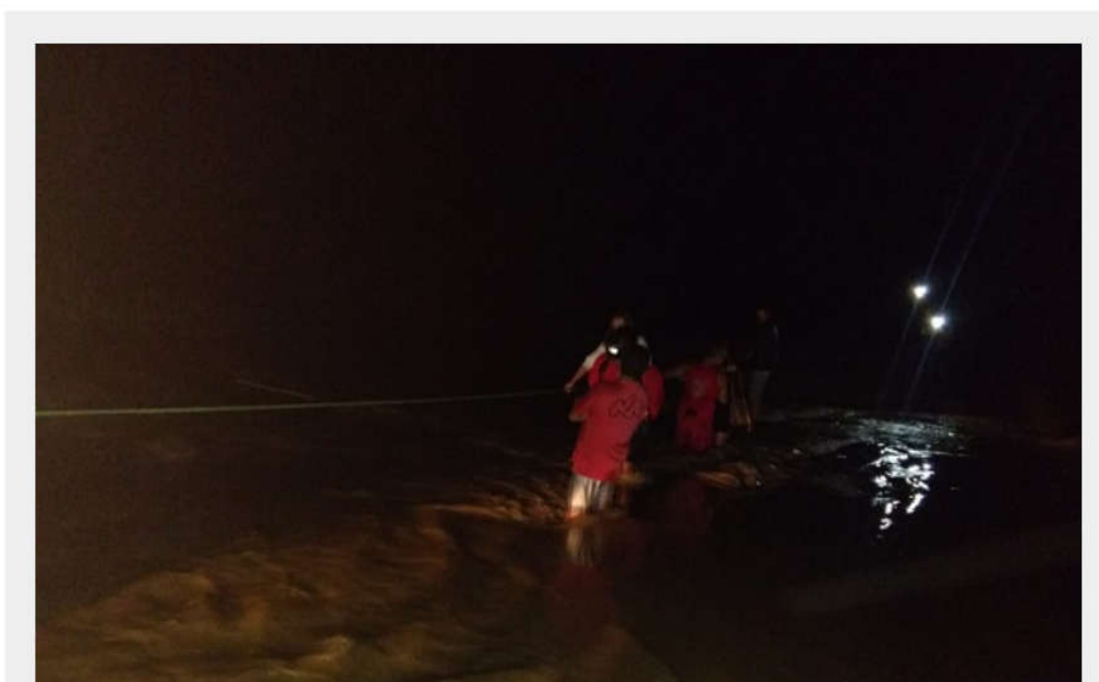
Imagem VIII - Universitário atravessam desvio feito ao lado da ponte destruída sobre o riacho do pequi em Bodocó-PE.
